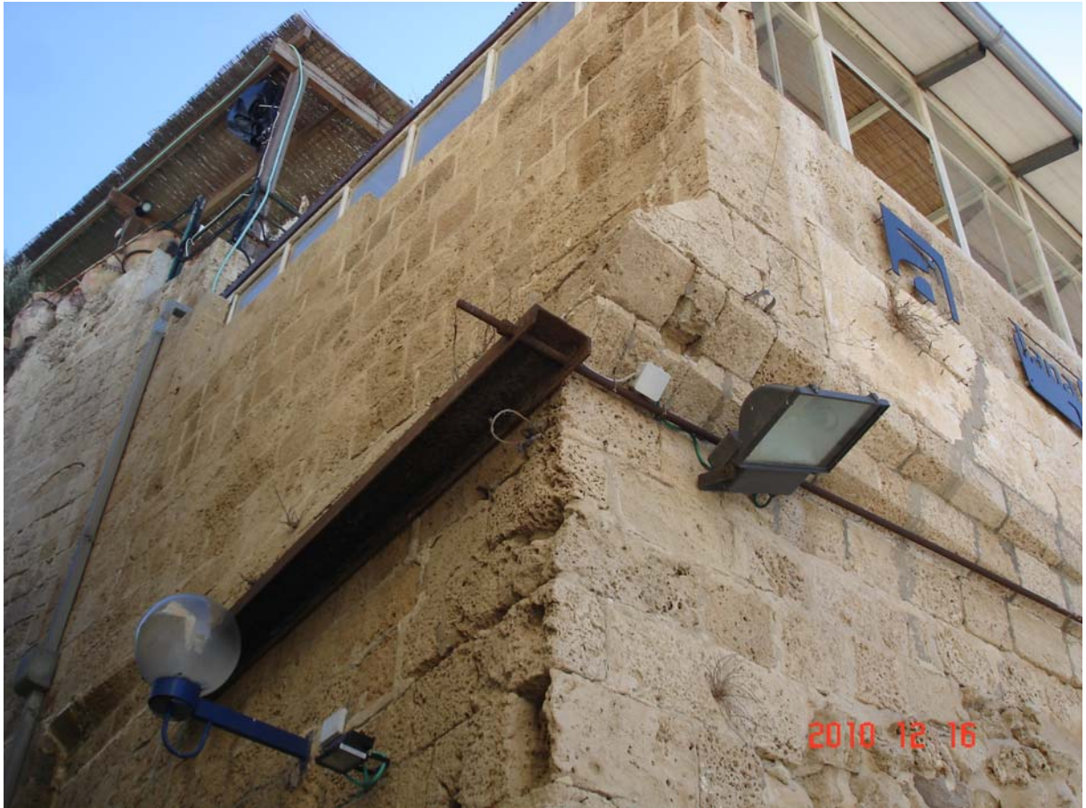
Яффа. Несколько грубоватая конструкция усиления отделяющей стены здания. Художникам – есть над чем подумать
