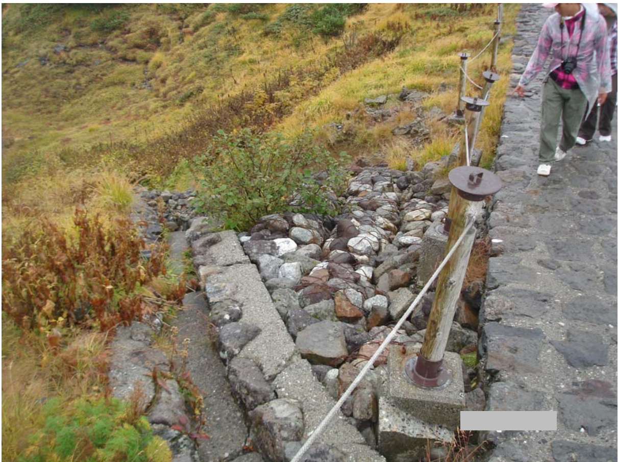
Укрепление откоса: просто и красиво (так тоже бывает)
