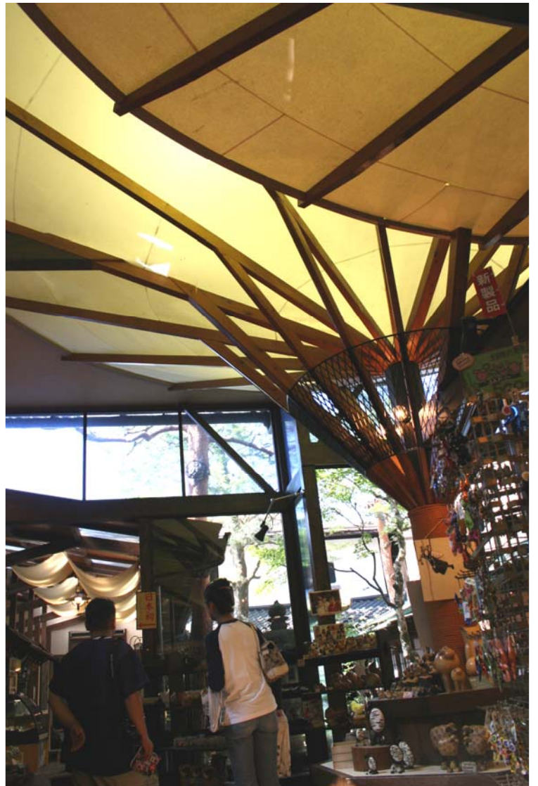
Интересные конструкции покрытия павильона. Очевидно, это «летний» вариант: лёгкое покрытие на деревянном каркасе. Влага, очевидно, собирается в центральную трубу и уходит в ливневой сток
