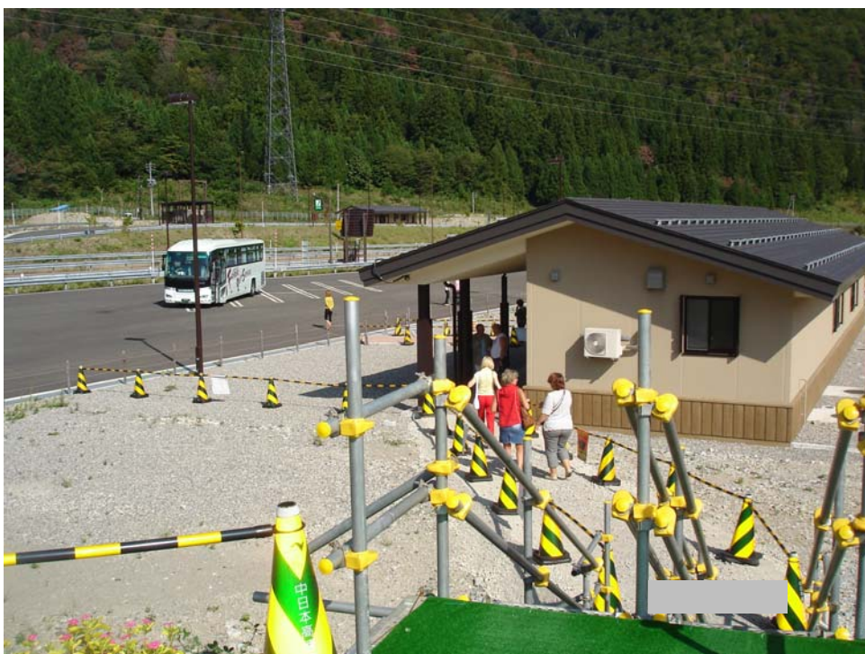
Общественный туалет и разноцветное ограждение стройплощадки
