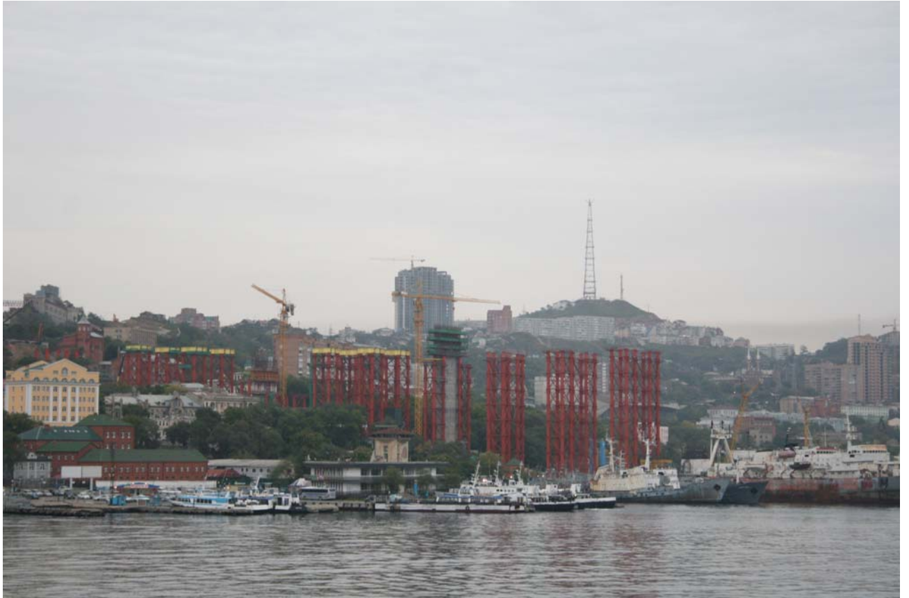
Опоры моста через бухту Золотой Рог. Оранжевые с жёлтыми шапочками – временные, серые бетонные – капитальные
