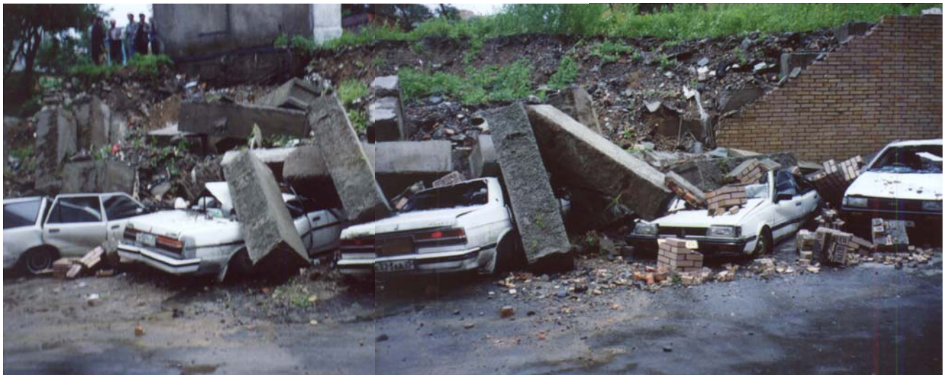
Обрушение подпорной стенки из сборных железобетонных блоков (2001г.)
