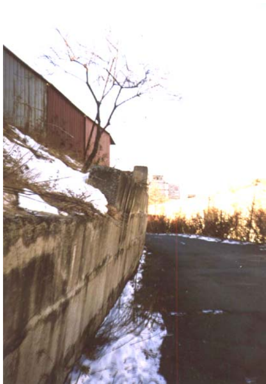
Устройство на поверхности засыпки сооружений, не предусмотренных проектом
