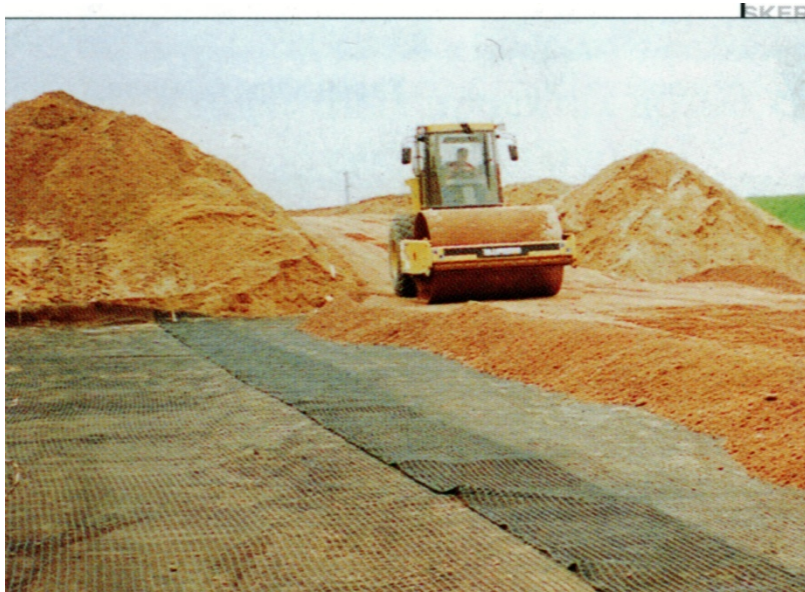
Фрагменты процесса изготовления подпорной стенки из армированного грунта
