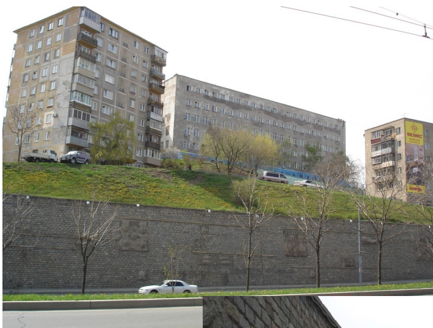
Различные подпорные сооружения в городской застройке
