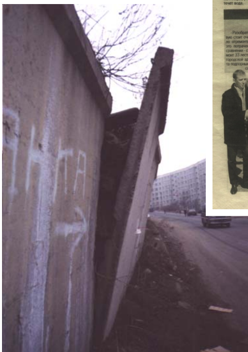
Разрушение уголкового подпорных стен из сборных железобетонных плит (1998 – 2002г.г.)
