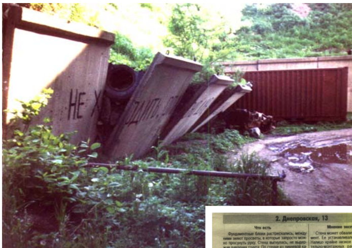
Обрушение подпорной стенки из сборных железобетонных блоков (2001г.)
