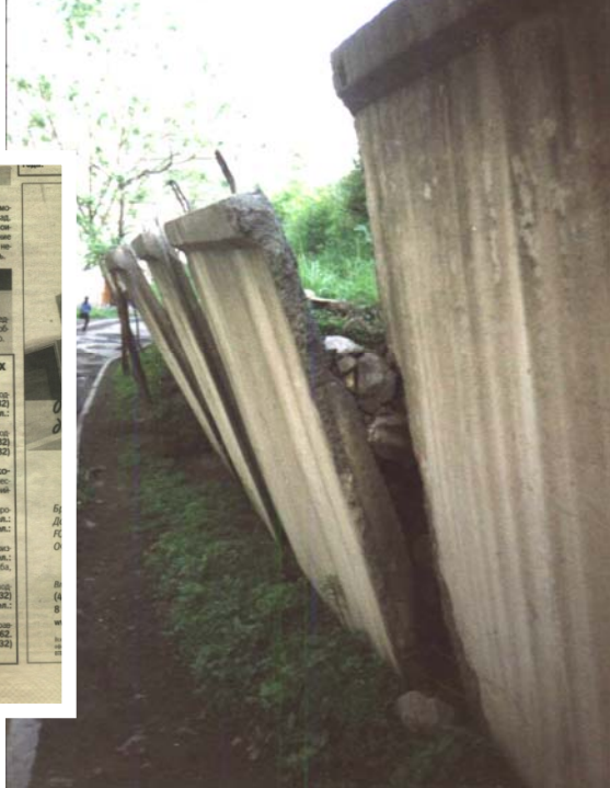
Разрушение уголкового подпорных стен из сборных железобетонных плит (1998 – 2002г.г.)
