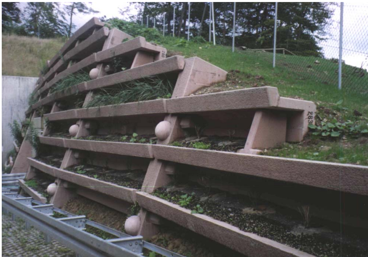
Подпорные стены комбинированного типа в г. Штуттгарте (Баден – Вюртемберг, Германия)
