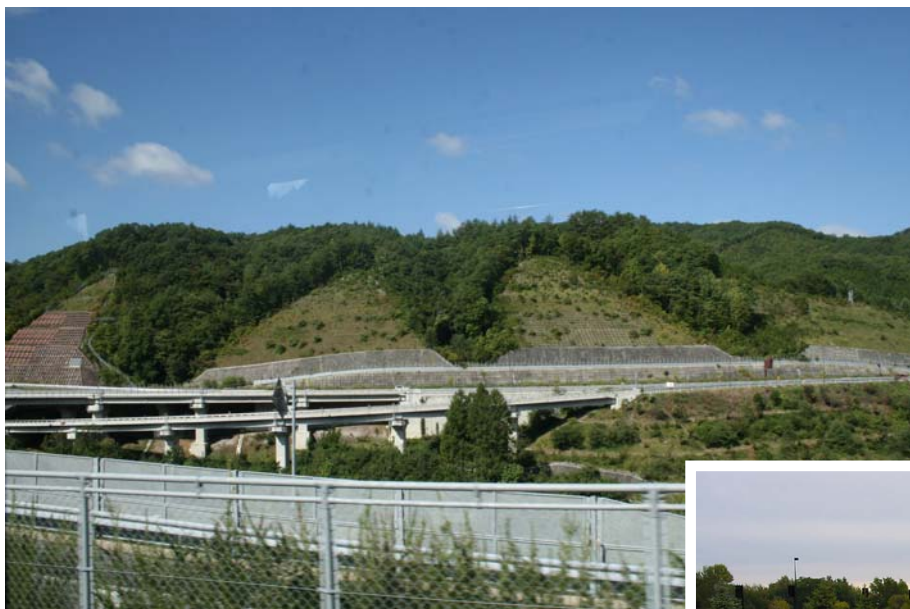
Рис. 13. Подпорные сооружения могут быть функционально связаны с лестницами, дорогами, проходами. Как правило, такое совмещение обладает яркой архитектурной выразительностью
