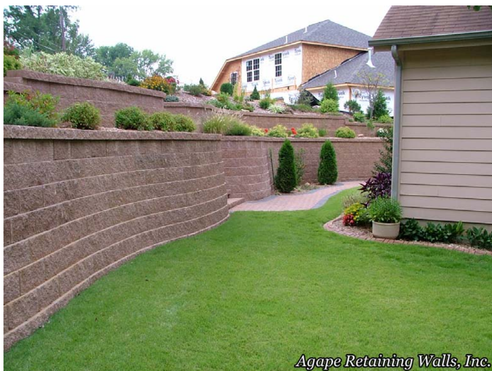
Рис. 11. Озеленение поверхности подпорных сооружений: устройство террас для зелёных насаждений
