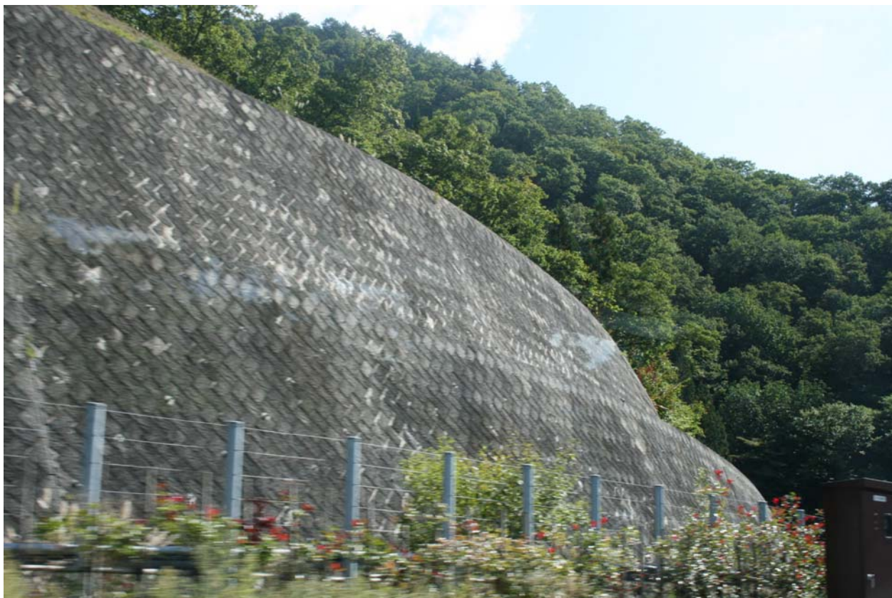
Рис. 14. Интересные формы и решения подпорных сооружений: стена из армированного грунта с выпуклой лицевой поверхностью (вверху) и тонкие заанкеренные в грунт стенки, укрепляющие поверхность откоса
