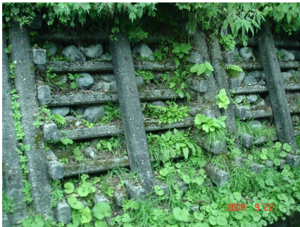
Рис. 9. Ряжевая подпорная стенка, состоящая из железобетонных «венцов» и каменной наброски
