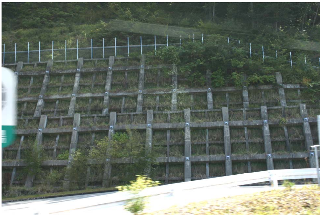
Рис. 14. Интересные формы и решения подпорных сооружений: стена из армированного грунта с выпуклой лицевой поверхностью (вверху) и тонкие заанкеренные в грунт стенки, укрепляющие поверхность откоса
