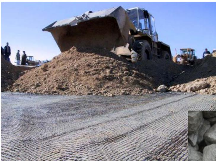
*Рис. 10. Фрагменты процесса изготовления подпорной стенки из армированного грунта*
