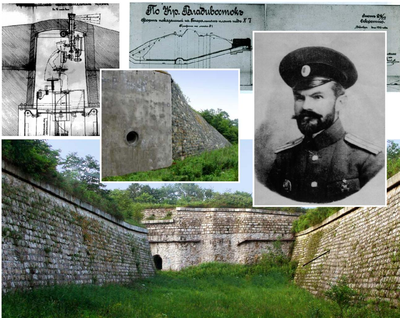
*Рис. 5. Пример применения массивных подпорных сооружений в военной фортификации (г. Владивосток, Россия). Куратор строительства - известный военный зодчий, русский фортификатор Вячеслав Сергеевич Тóронов (фото начала XX века)*
