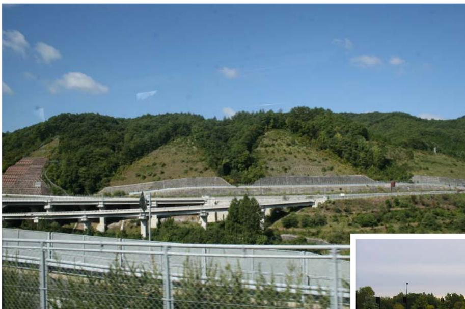
*Рис. 16. Подпорные сооружения могут быть функционально связаны с лестницами, дорогами, проходами. Как правило, такое совмещение обладает яркой архитектурной выразительностью*
