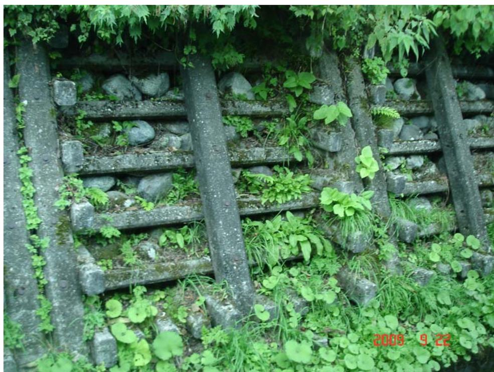
*Рис. 12. Ряжевая подпорная стенка, состоящая из железобетонных «венцов» и каменной наброски*
