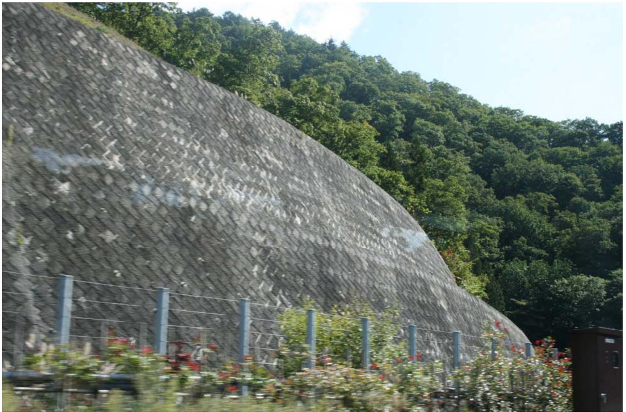
*Рис. 17. Интересные формы и решения подпорных сооружений: стена из армированного грунта с выпуклой лицевой поверхностью (вверху) и тонкие заанкеренные в грунт стенки, укрепляющие поверхность откоса*
